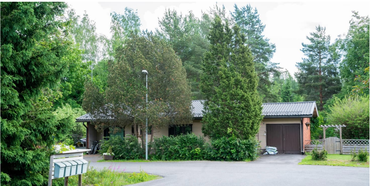
51 Martanpihalla sijaitseva tyypiltään pitkänomainen asuinrakennus on materiaaleiltaan alueelle tyypillinen: muuratut päädyt ja vaakalaudoitus pitkällä julkisivuilla. Katto on aaltoprofiilipeltiä.
