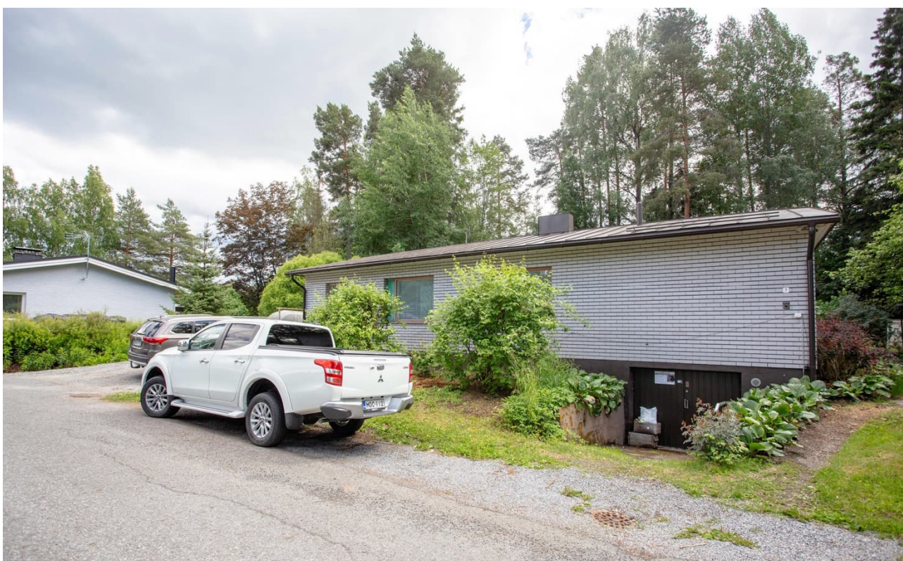
55 Rakennus Lauranpihan alusta. Vaikka monessa alueen rakennuksessa on kellarikerros, ei se usein näy kadulle. Kellarissa sijaitseva autotalli on harvinainen poikkeus.
