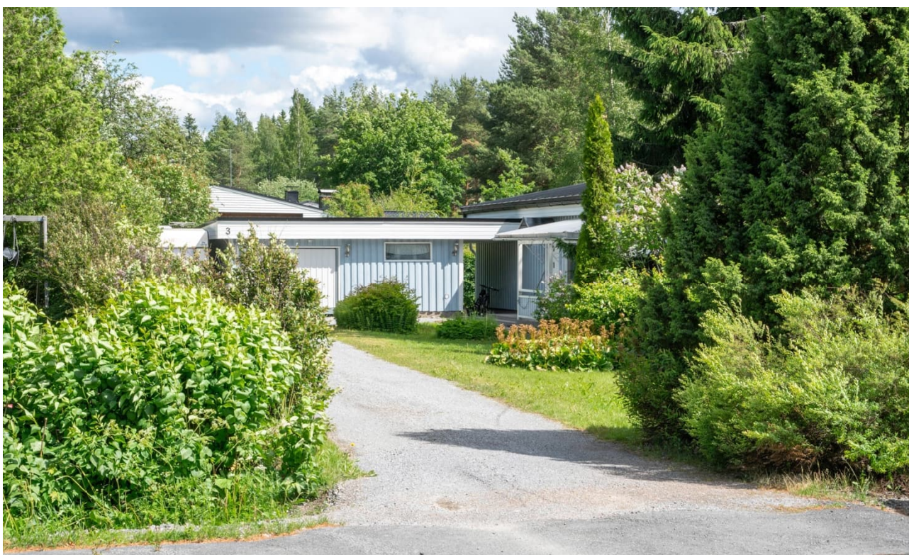
69 Kulmatontti Mervinpihalta. Autotalli on muusta rakennuksesta erillinen, mutta yhdistyy päärakennukseen katoksella.
