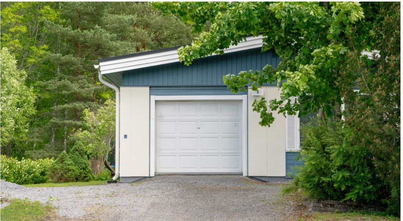
75 Betonirunkoinen rakennus Mirjanpihalla on poikkeus rakennuskannan julkisivumateriaaleissa.
