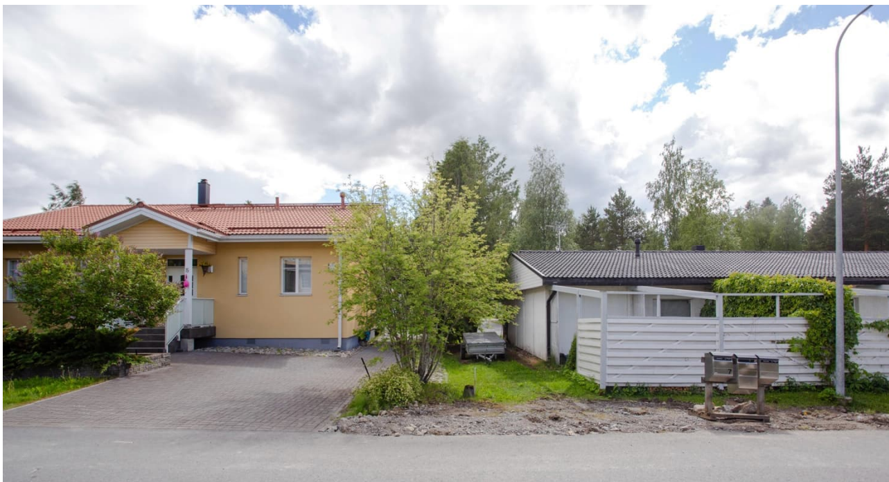
77 Näkymä Penttiläntieltä. Oikealla 2000-lukuinen rakennus, vasemmalla Lauranpihaan kuuluva vanhempi rakennus. Näkymässä havainnollistuu, miten nykymääräysten mukainen matalakin rakennus on profiililtaan korkeampi kuin Turrin alueen 1960-luvun rakennuskanta.
