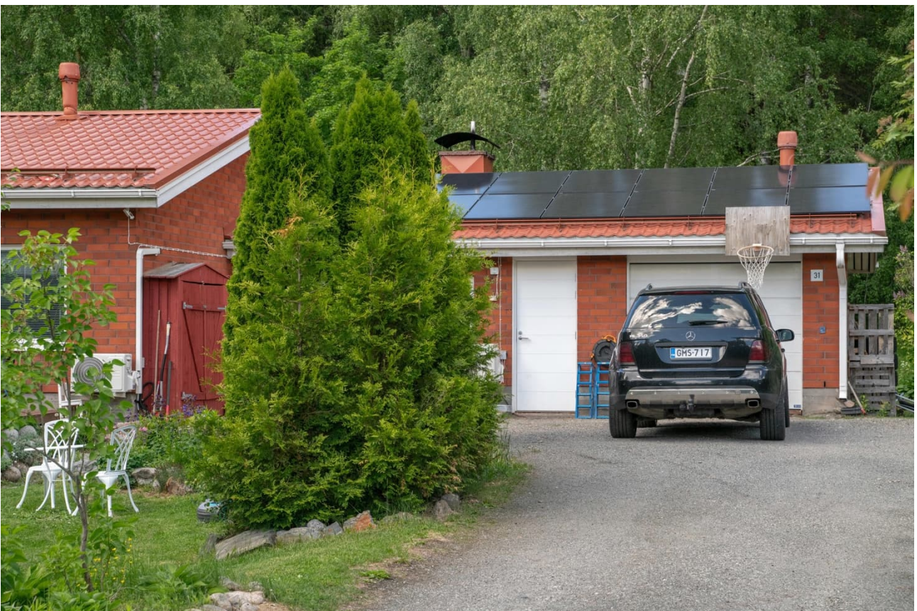
47 Näkymä Turrintieltä. Kuvassa havainnollistuu hyvin, miten nykyinen autokanta ei ole enää yhteensopiva 1960-luvun autotallimitoituksen kanssa. Etelään antava katon lape on aurinkoenergian keräämiseen ihanteellinen.
