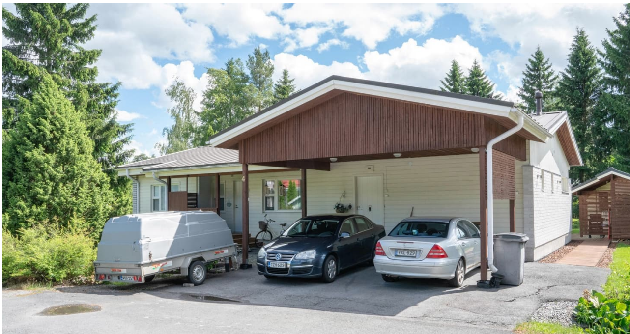
48 Mervinpihan kiinteistöön rakennettu autokatos on hyvin lähellä katulinjaa ja alueelle muutenkin turhan kookas elementti.
