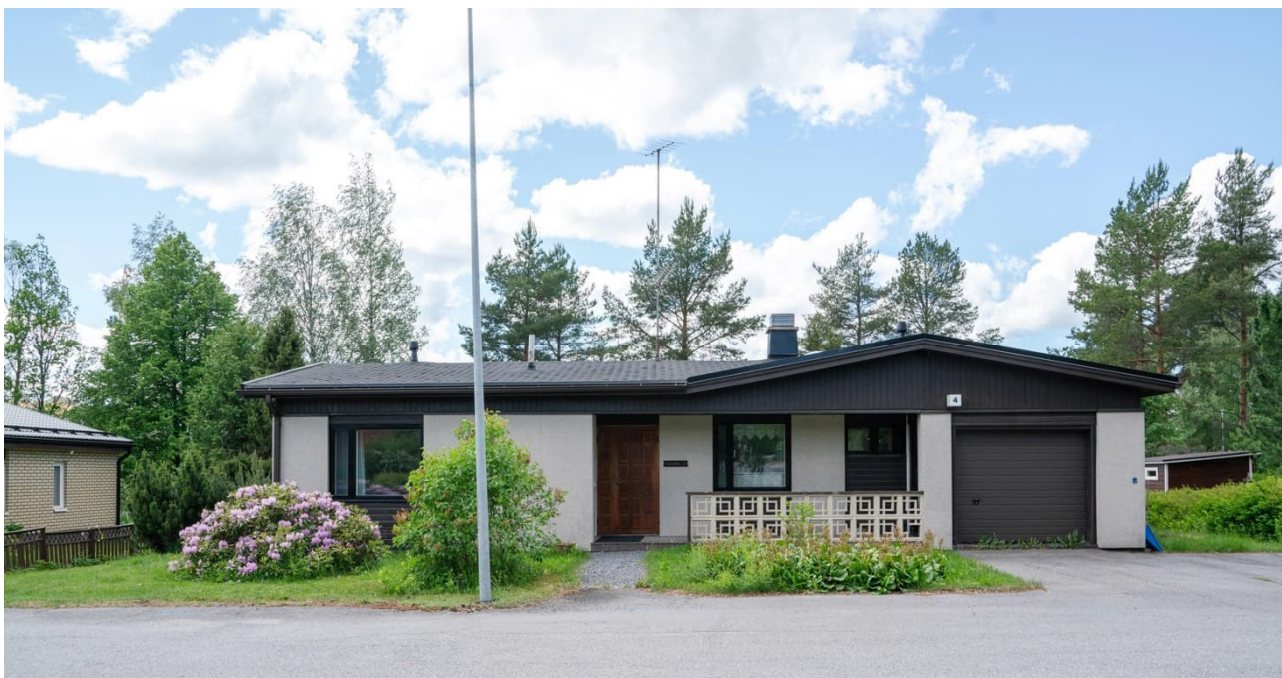
53 Talo Mirjanpihan päässä. Julkisivumateriaali on rapattu levy.
