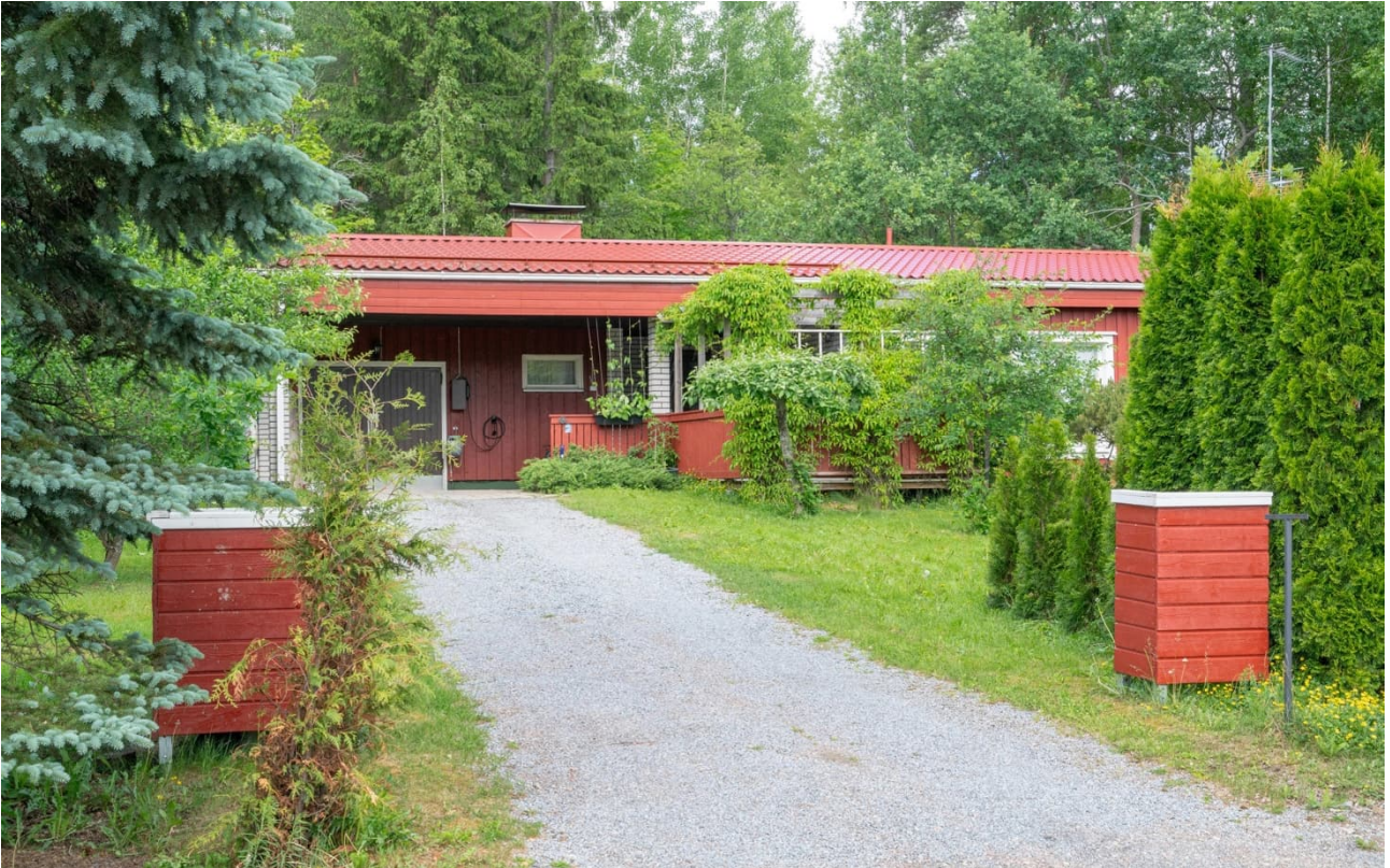
58 Turrintien varren rakennukset ovat perusolemukseltaan suorakaiteen muotoisia. Talon jommassakummassa päädyssä sijaitsevat tyypilliset autotalli, varastoja, kylpytilat ja taloteknisiä tiloja.
