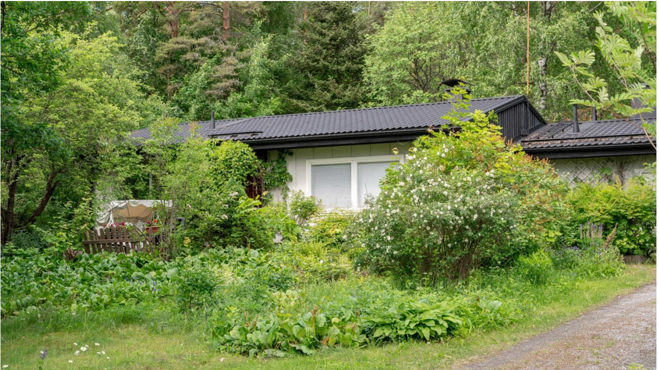
60 Minerit-julkisivuja esiintyy alueella suhteellisen harvassa. Tässä Turrintien varrella sijaitsevassa talossa se on rakennuspiirustusten mukaan alkuperäinen julkisivumateriaali.
