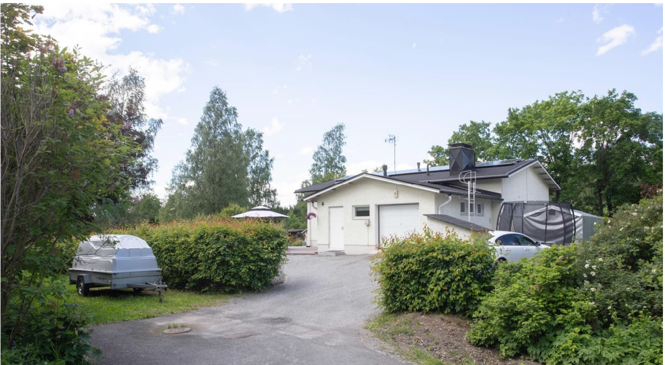
67 Näkymä Mairenpihalta. Puutalo-tyyppin rakennusta on laajennettu myöhemmin autotallilla. Rakennuksen kokonaishahmo ei ole kovin selkeä.
